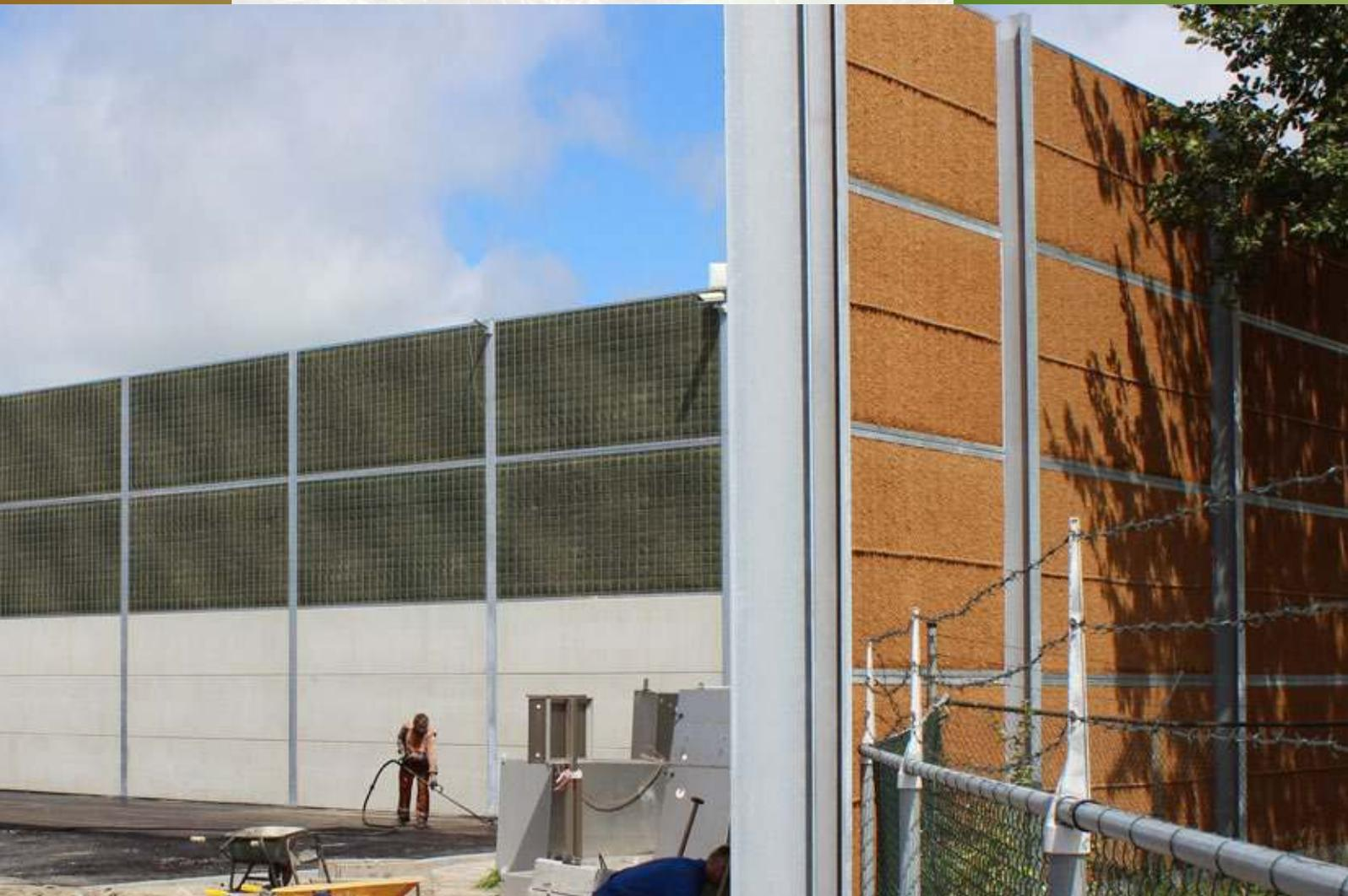
*Die Kokowall® HA-MinWol Schallschutzwand ist eine Lärmschutzwand mit einer Außenseite aus Kokosfasern (begrünt) und einer Innenseite als absorbierende Schicht aus Mineralwolle, einem PE-Kunststoffgitter und einem verzinkten Stahlgitter (unbegrünt).*
