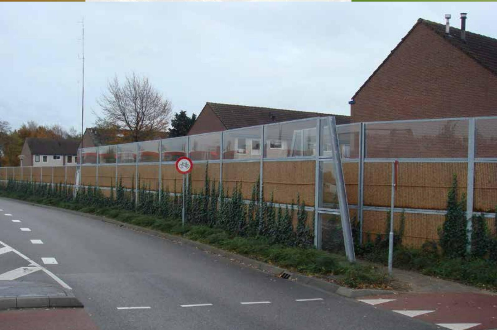
*Eine warme Ausstrahlung, die in jede Umgebung passt. Das sind die kennzeichnenden Merkmale der Kokowall® Lärmschutzwände. Die Außenseite der Wände besteht aus langlebigen Kokosfasern. Neben einer erheblichen Geräuschabsorption bieten Kokosfasern einen idealen Untergrund für verschiedene Kletterpflanzen. In wenigen Jahren ist eine Kokowall® Lärmschutzwand vollständig begrünt.*
